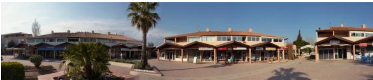
Résidences Les Seychelles et centre-commercial à la Baie des Isles.
