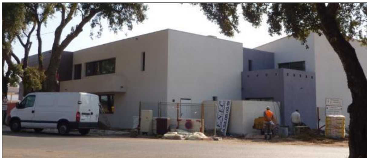
Les bâtiments de la nouvelle école A. Bussonne
