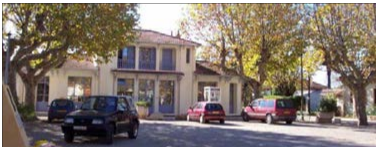
Vue de l'espace public central du quartier des Bormettes
