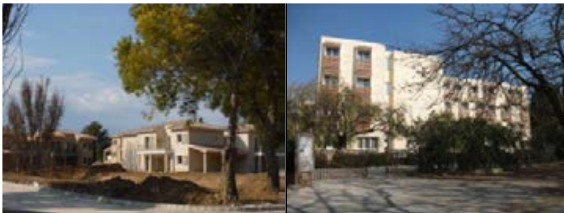
Constructions et rénovations sur le site de l'Agelonde
