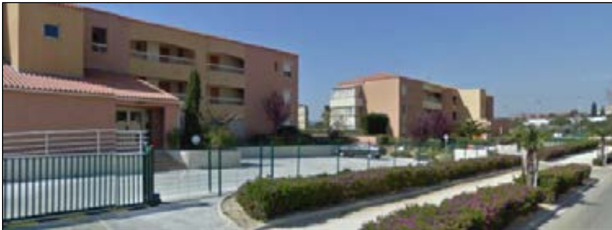
L'habitat collectif du Boulevard de la Plage de l'Argentière
